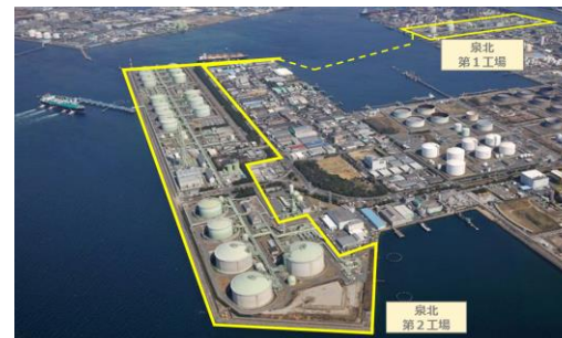
高速無線ネットワークを導入した泉北製造所
