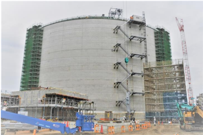
愛媛工場に、国内最大級(容量23万KI) のLNGタンクを建設中
