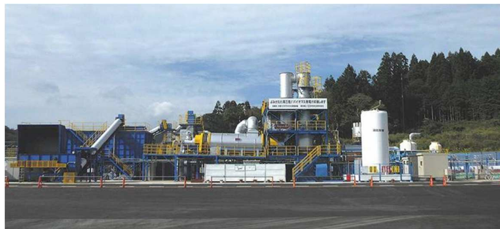
バイオマス設備
