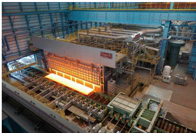
ウォーキングビーム型鋼片加熱炉
