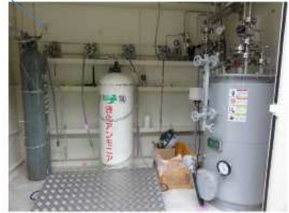
アンモニア供給設備
