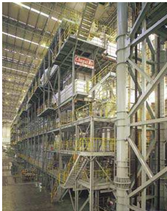
冷延鋼板連続焼鈍設備 (CAL)
