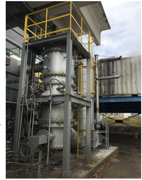
除害炉 + 冷却塔
