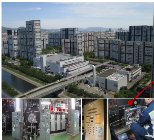
住戸内熱設備修理
