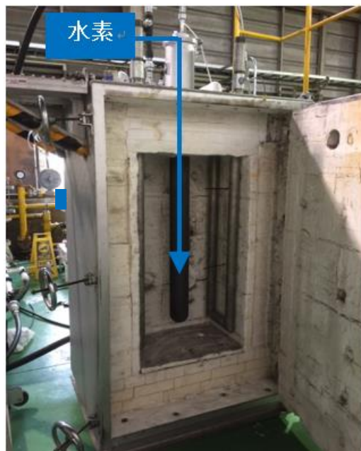
東邦ガス 水素燃焼試験場
