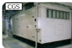
CGS・・・耐震性の高い中圧導管により供給される都市ガスを燃料として電気をつくり、同時に発生する熱を冷房・暖房・蒸気などに利用できるシステム。
