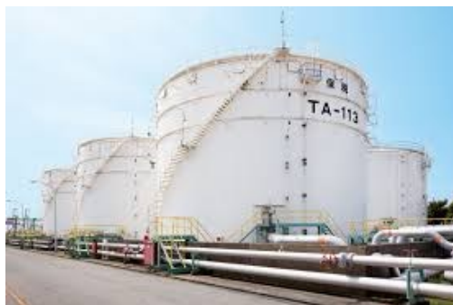
(貯蔵タンクの定期点検)
