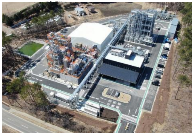
岩手県久慈市に完成した実証プラント
