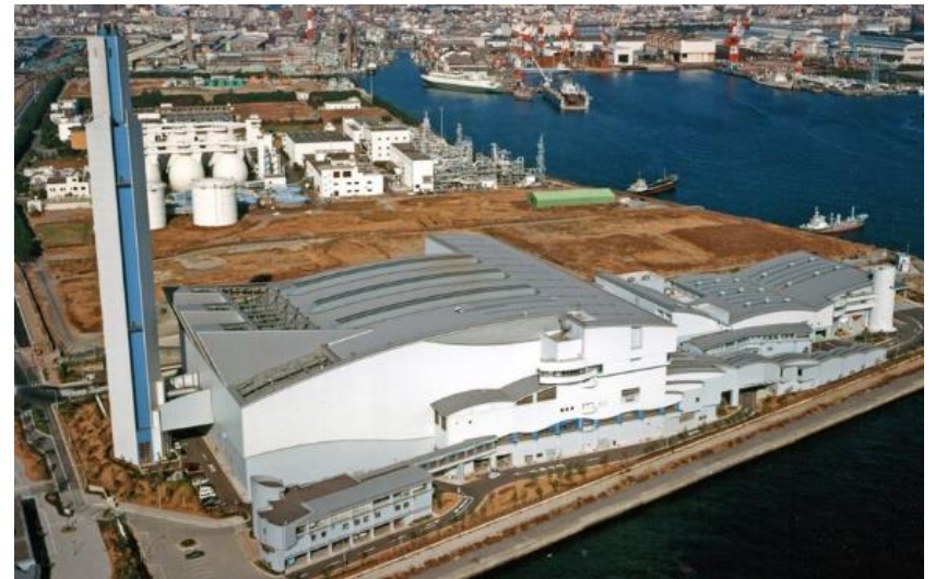
実証試験を行う横浜市資源循環局鶴見工場
