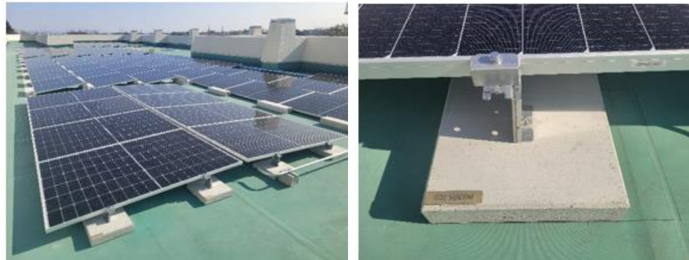
横浜市立元街小学校に導入した太陽光発電設備とCO 2 -SUICOM
