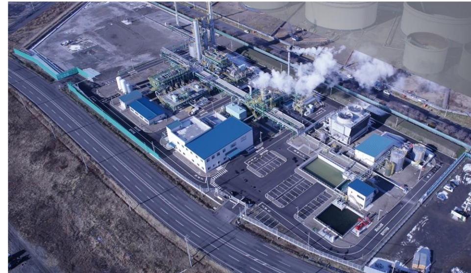
苫小牧CCS実証試験センター
