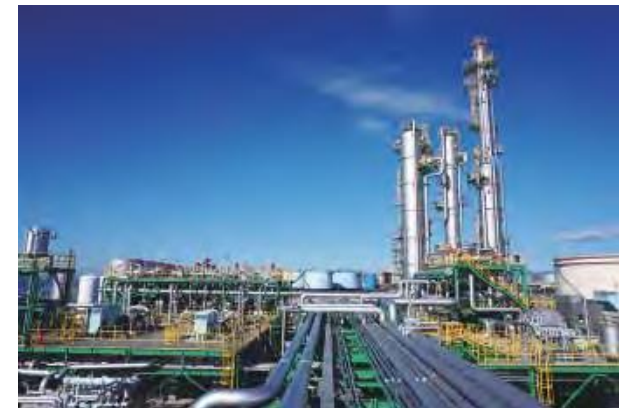
苫小牧におけるCCS実証プロジェクト <出典>「CCS実証プロジェクトが苫小牧で実施されています」 日本CCS調査株式会社
