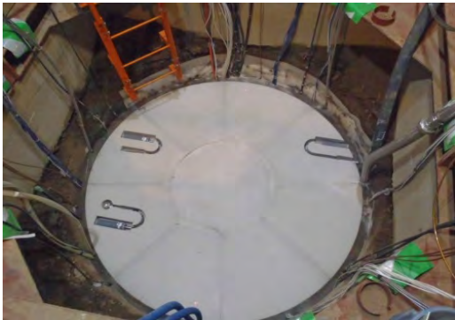
地下施設で実証中の地中無線装置
