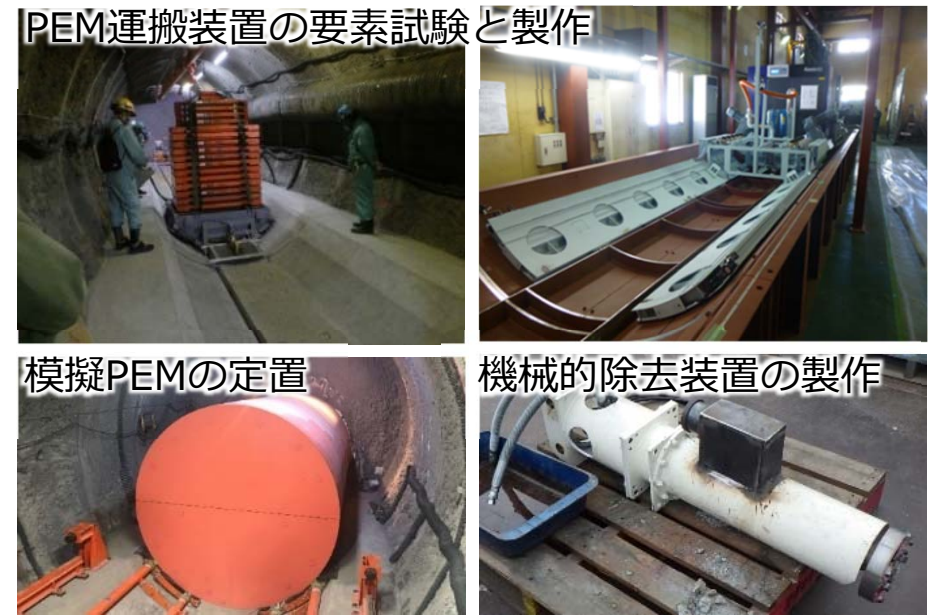
図1 横置きPEM方式で定置された模擬廃棄体の回収技術に係る検討状況
