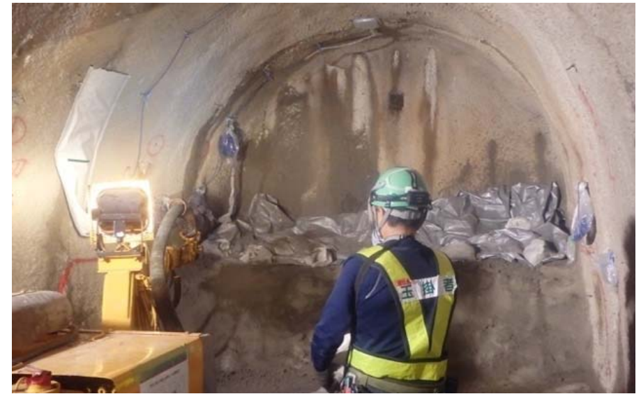
図1 坑道全断面吹付け工法による埋め戻し施工試験の状況
