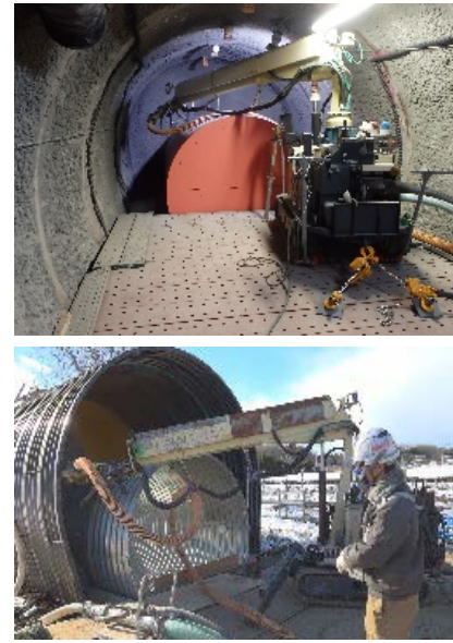
2) 隙間充填 （開放部吹き付け工法）
