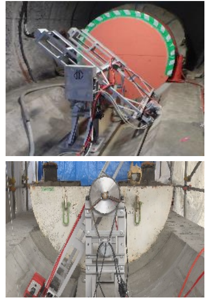
3) 充填材除去 （ウォータージェット、オーガ掘削）
