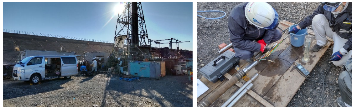
図1 駿河湾沿岸部でのボーリング掘削と流向流速計の調整
