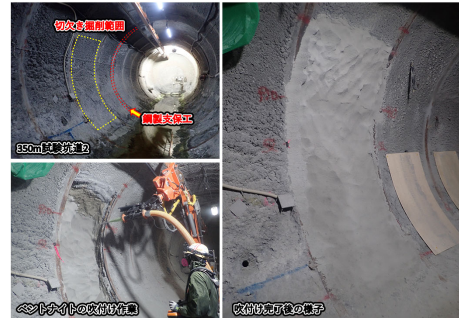
図1 坑道側壁部におけるベントナイト吹付け試験の状況
