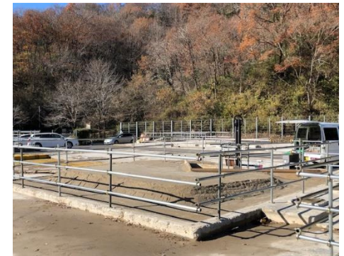
換気立坑工区 研究坑道埋め戻し完了 (R3.12.2完了)
