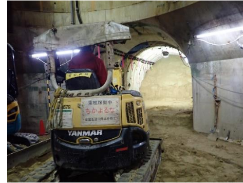
主立坑（直径6.5m） 深度100m予備ステージの 埋め戻し作業の様子
