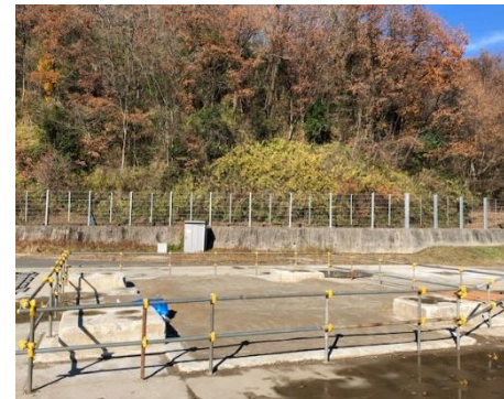
主立坑工区 研究坑道埋め戻し完了 (R3.11.18完了)
