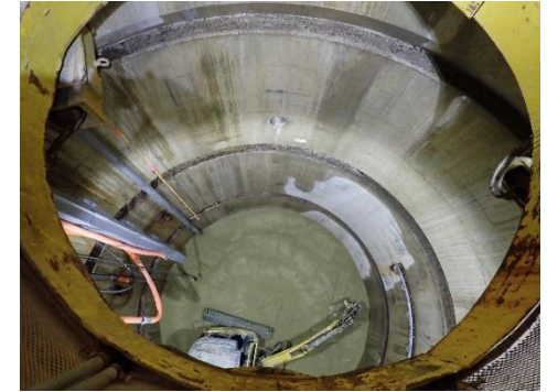
換気立坑（直径4.5m） 深度90m予備ステージの 埋め戻し作業の様子
