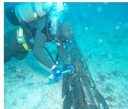
ダイバーによる防護管取付
