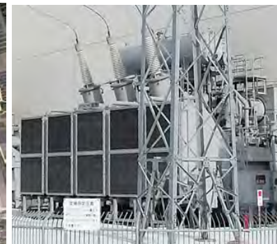
②変換用変圧器 サイリスタバルブに適した電圧に調整
