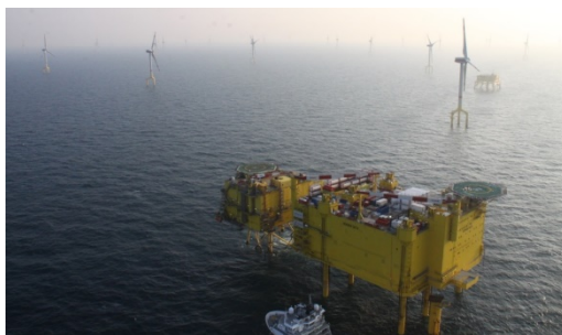
BorWin1&2 洋上変電所
