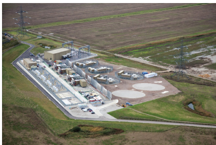
London Array陸上変電所 "Source: London Array Limited"
