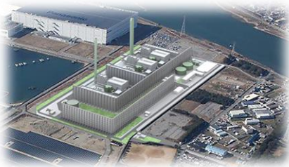
姫路ガス発電所 125万kW(建設中)
