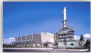
中山ガス発電所 15万kW
