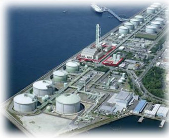
泉北ガス発電所 110万kW
