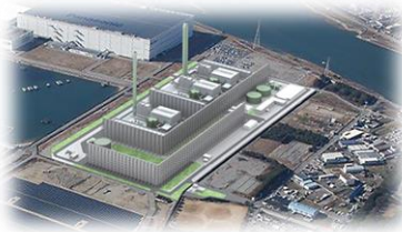
姫路ガス発電所 125万kW(建設中)
