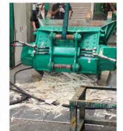
④ FRPブレード 破碎開始
