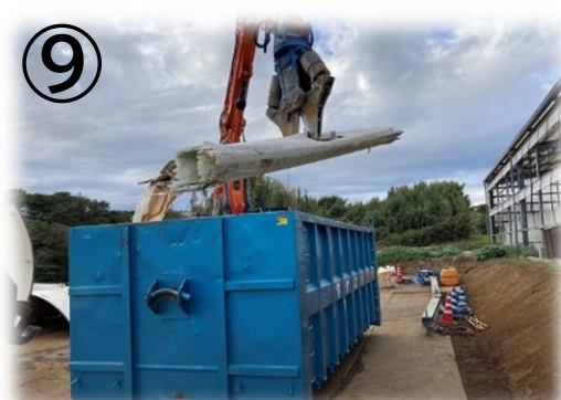
⑨ 《産廃(ブレード)搬出》 重機を使用し車両へ積込、搬出し ます。(搬出計画によるサイズ・重量)
