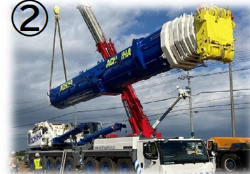
《メインクレーン組立》
