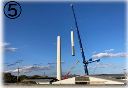
⑤ 《タワートップ下架》 フランジ部の接続ボルト及び ナットを外し下架します。
