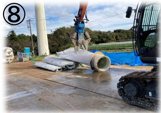
⑧ 《ブレード裁断》 重機のカッターを使用しブレードを トラックスケールに裁断します。
