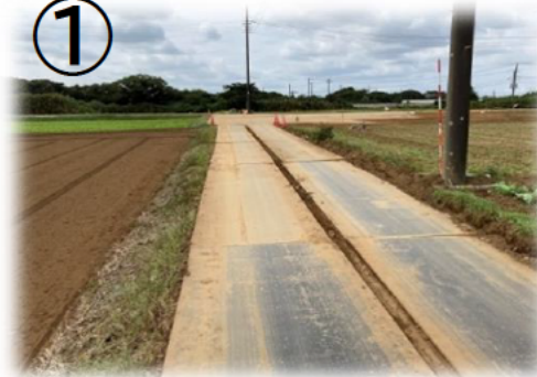
《整地・鉄板敷設》
