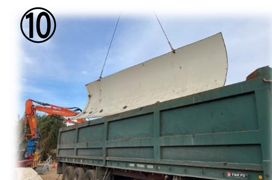
⑩ 《スクラップ搬出》 重機を使用し車両へ積込。
