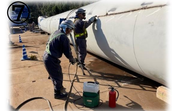
⑦ 《タワー裁断》 サイズ・重量を搬出可能な物に する為ガス溶断します。
