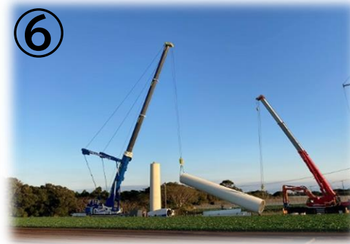
⑥ 《タワーミドル・ボトム下架》 タワー下部を相番クレーンにて支持 し横倒しの状態にして下架します。
