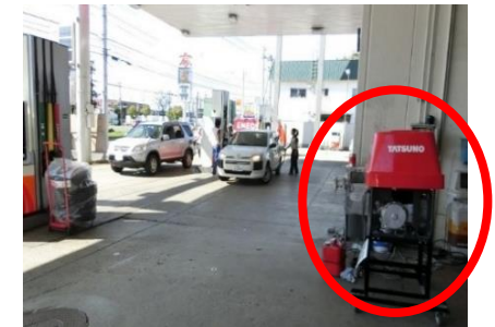
停電直後から、自家発電機を稼働させて給油を継続した中核SS (北海道札幌市／2018.9.6撮影)
