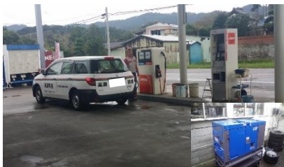
自家発電機を稼働させて、給油を継続したSS（千葉県鴨川市）
