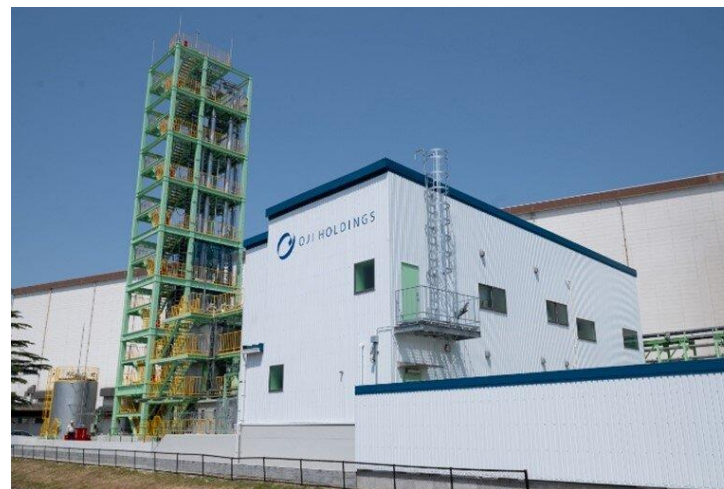
パイロットプラントの外観
