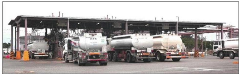
図2-29 ローリーラック全体
