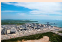
イクシス LNGプロジェクト
