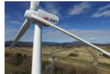
風車ブレードの空気の流れを制御するシリコンゴムの実証研究
