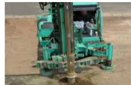
地中熱交換器を埋設するための掘削工法の実証
