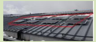
あづま総合運動公園屋根面
