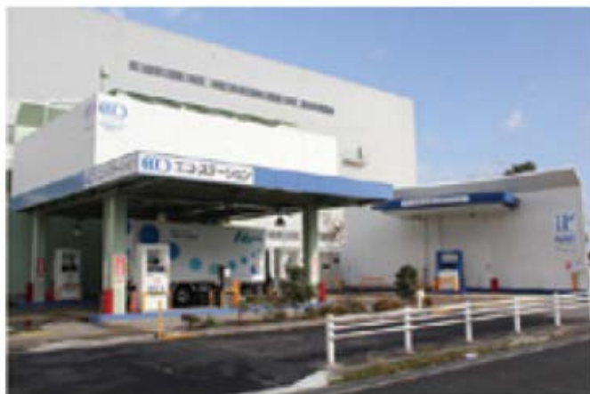
水素ステーション
