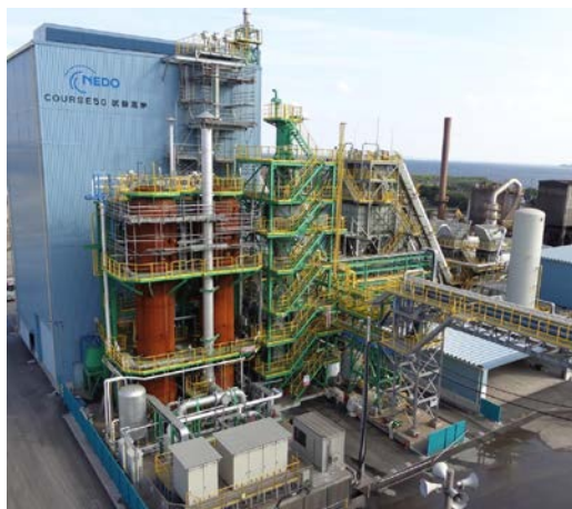
COURSE50試験高炉
