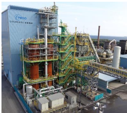
COURSE50試験高炉
