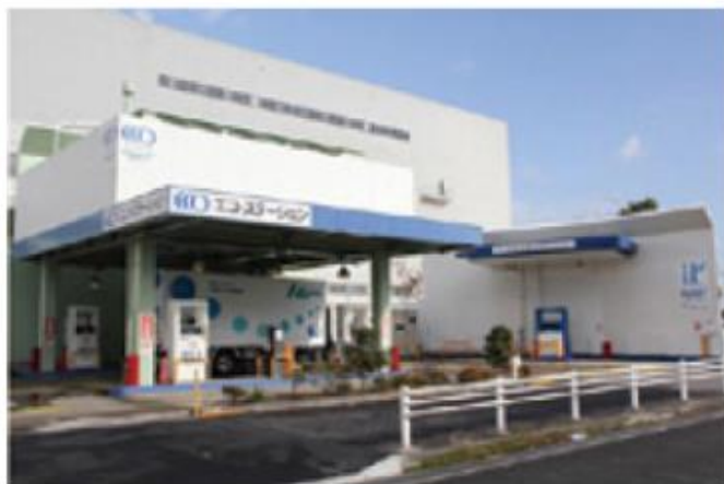
水素ステーション
