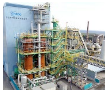
COURSE50試験高炉
