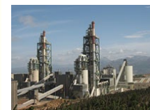
セメントプラント
