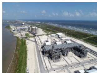
フリーポート LNG プロジェクト液化設備の第1系列 FLNG Development 社提供
