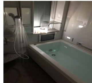
給湯により入浴が可能
