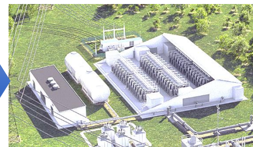
100MW級モジュール連結式システム
