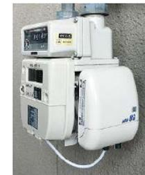
ガスメーターの横に通信ユニットを設置し、指針をIOT等で集約し、AIが最適な配送時期を提案する
