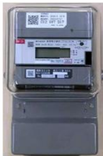
(関西電力・九州電力)
