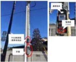
現在のスマートメーター設置場所(1号柱)から計器移設場所(店舗壁面)の距離を約35mとした場合の工事。移設工事の前に1号柱から店舗壁面までのケーブルルートを準備(地中埋設路の確保または壁面への吊架支持点設置)する必要がある。その金額が高額
