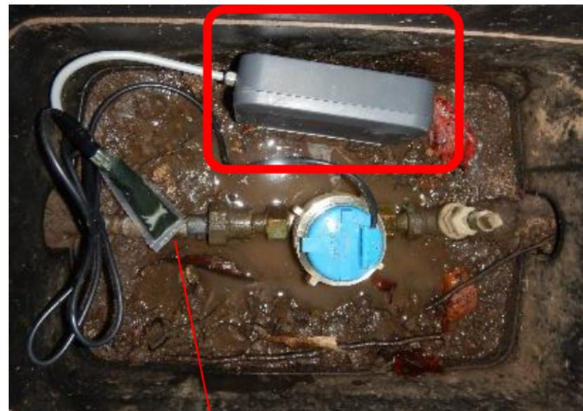
本例ではケーブルをレジンキットにより防水接続している。
