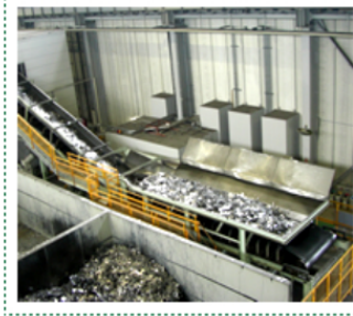
材料投入用ベルトコンベア
