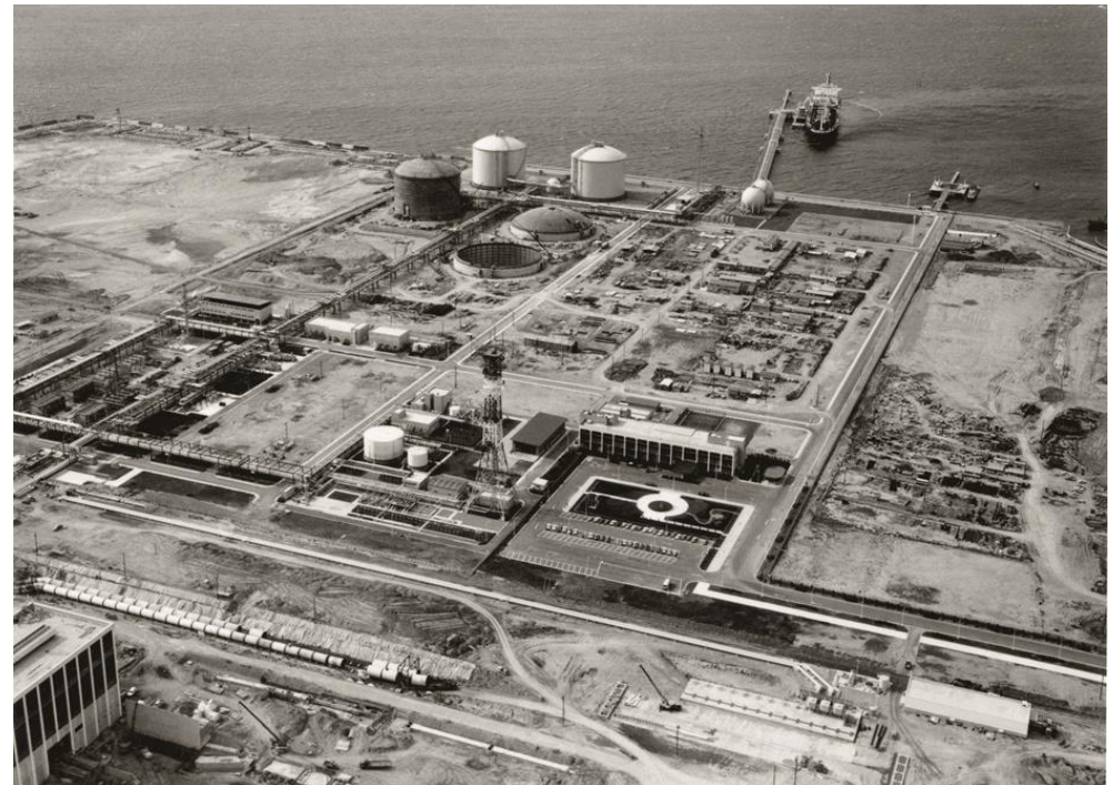
新工場：袖ヶ浦LNG基地が稼働（1973年）
