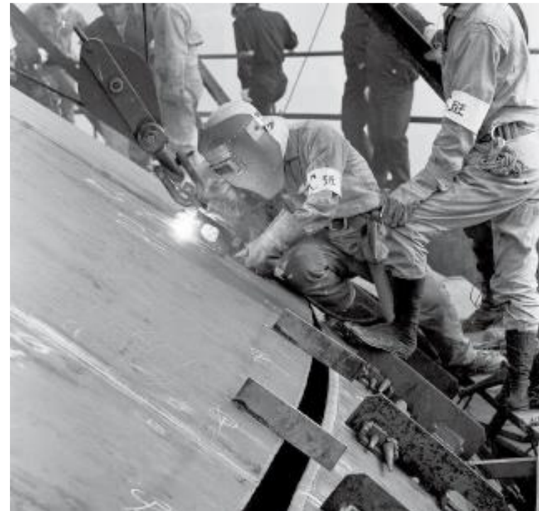
LNG貯蔵タンクの溶接
