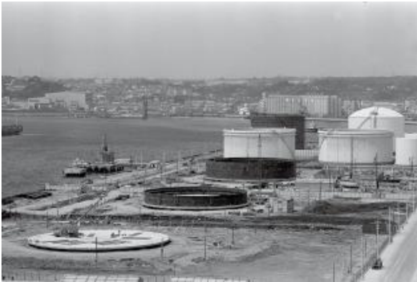
根岸LNG基地建設の様子
