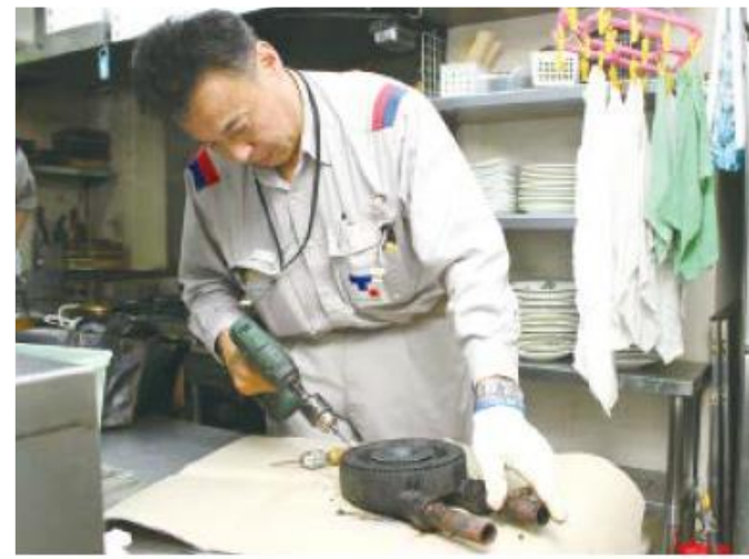
燃焼確認を行った後、燃焼状態を良好にするためにバーナー部を分解し油汚れを取り除く(2019年8月、魚民 四街道北口駅前店様での作業)。
