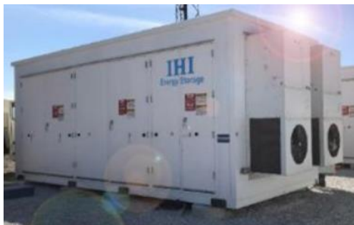
蓄電池システム
