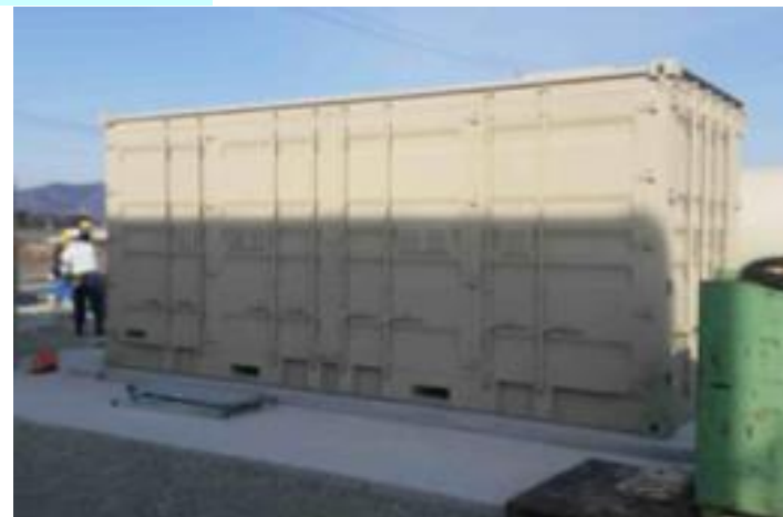
PEM型水電解装置 (30m 3 /h水素製造)
