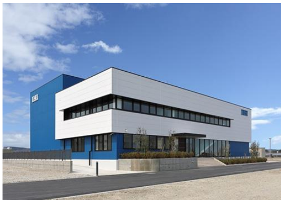
SIGCそうまラボ （水素研究棟）
