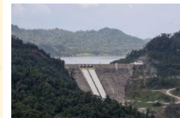
水力発電設備
