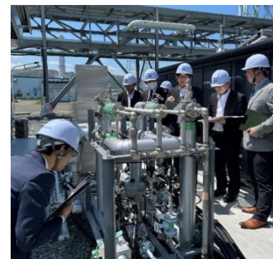
設備認定における現地調査の様子
