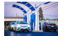
水素ステーション
