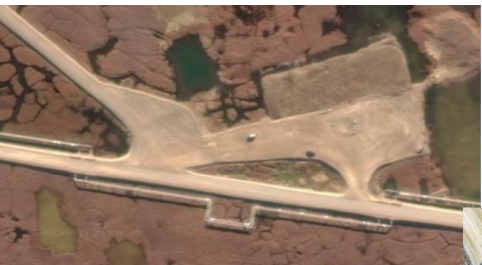
設備設置工事前
