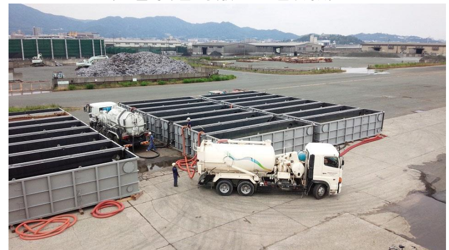
第二回海洋産出試験での生産水貯蔵タンク
