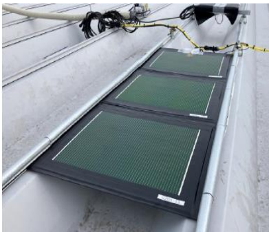
折板屋根への設置例
