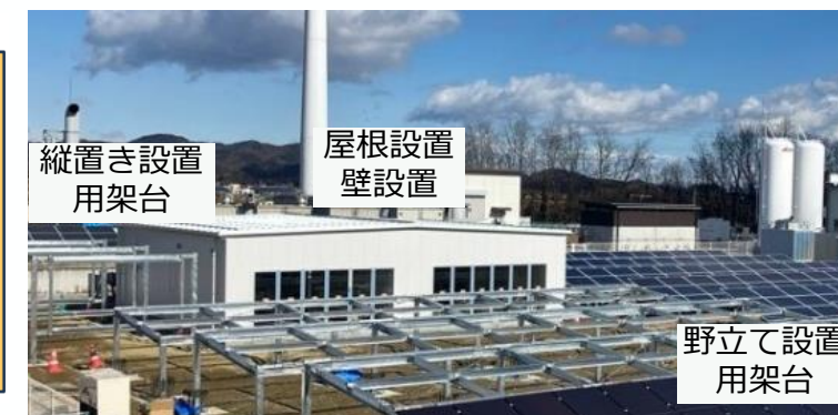
様々な設置形態を想定した実証フィールドの例 産総研より提供
