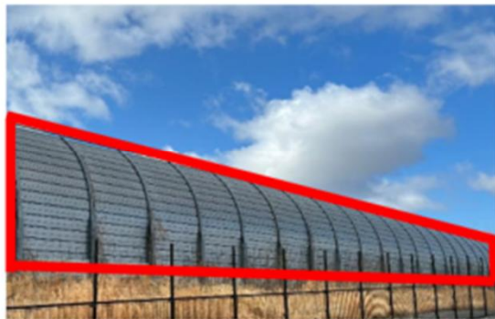
高速道路内の遮音壁の例（外壁） NEXCO西日本より提供
