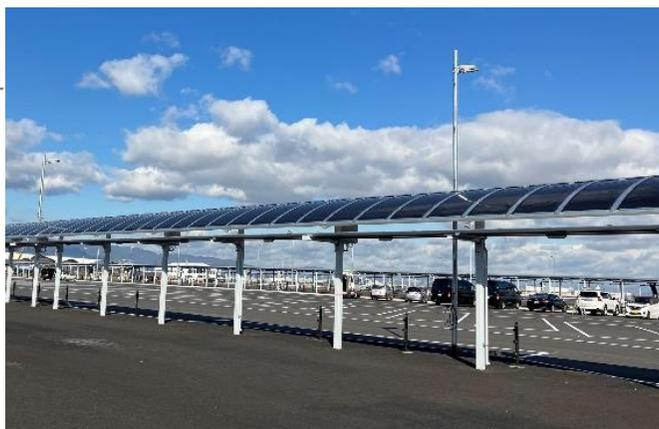
積水化学工業は、万博会場西ゲートバスターミナルに約**250m (世界最大級規模)**にわたりペロブスカイト太陽電池を設置。発電された電力は蓄電され、夜間LED照明用の電力として利用。
