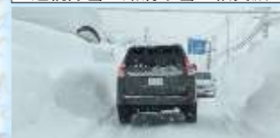
拡幅・運搬除排雪で幅員確保
