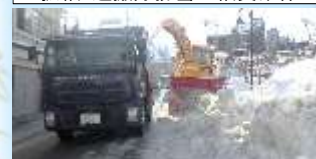
拡幅・運搬除排雪で幅員確保
