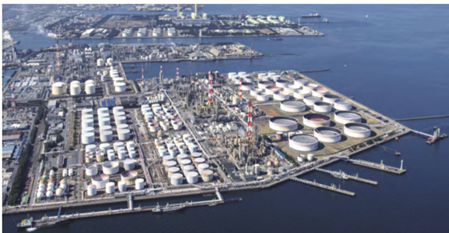
富士石油(株) 袖ヶ浦製油所（千葉県） 原油処理能力：143,000BPSD
