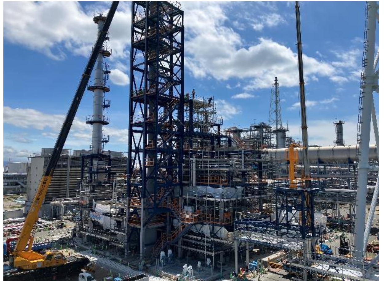
建設風景（24年6月21日撮影）
